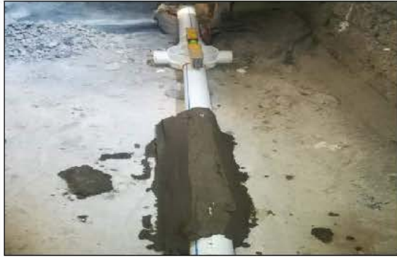
شكل رقم (٢٩) يوضح عمل ميول للصرف
