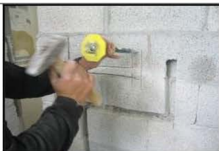
شكل رقم (٢١) مراحل تنفيذ المواسير البلاستيك
