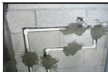
شكل رقم (٢١) مراحل تنفيذ المواسير البلاستيك
