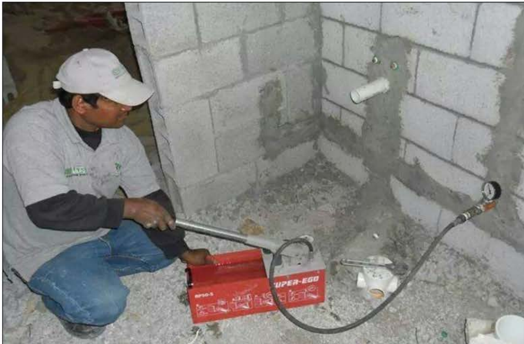
شكل رقم (٢٢) اختبار الكبس للمواسير بالمياه
