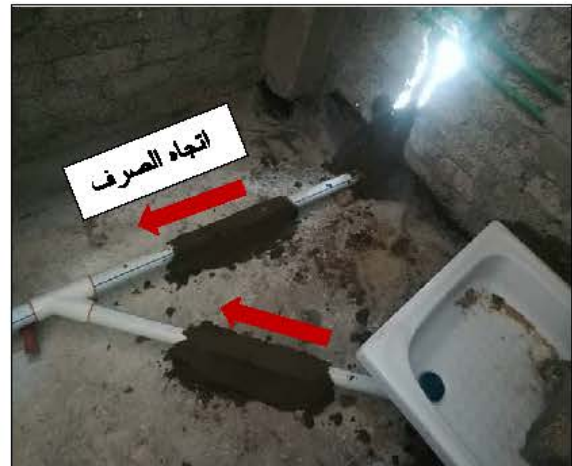
شكل رقم (٣٠) يوضح تثبيت المواسير وطرق اللقائها بزواوية ١٣٥
