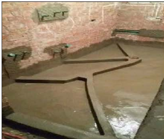
شكل رقم (٣١) يوضح حماية المواسير
