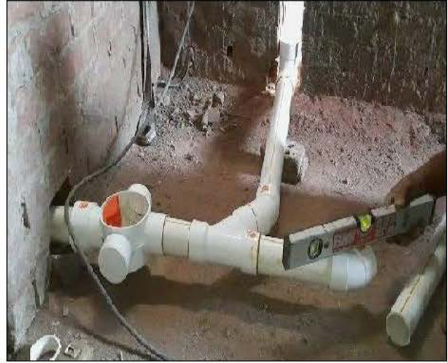
شكل رقم (٢٠) يوضح سيفون الأرضية وتوصيلاته
